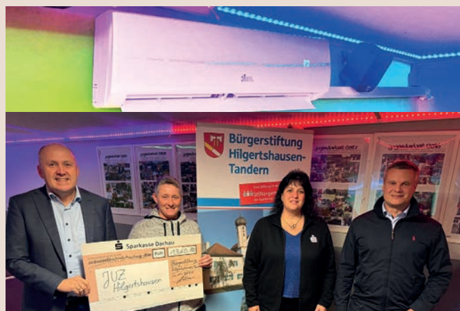
Die neue Heizung (Bild oben) sorgt für wohlige Wärme im JUZ Hilgertshausen, auch wenn es draußen kalt ist. Das freut auch Bürgermeister Markus Hertlein, JUZ-Leiterin Sonja Hudlberger sowie Susanne Boerner und Benjamin Bertl von der Sparkasse (v. l.). Foto: rds
